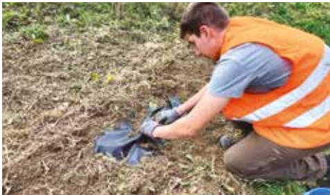
5. Riempimento manuale delle buche e compattamento del suolo
